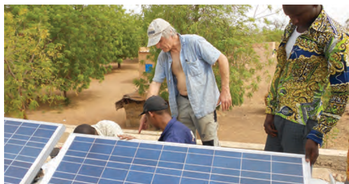
Installation de panneaux solaires sur la case de santé de Doga (Niger)
